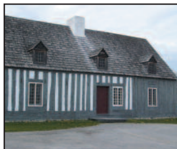
Maison Lamontagne : Site historique de la maison Lamontagne, Rimouski.
